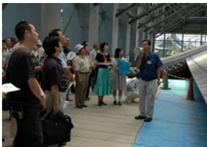
京都土物語 瓦の文化史 西本願寺御影堂 修復工事現場 寺本甚平衛氏
